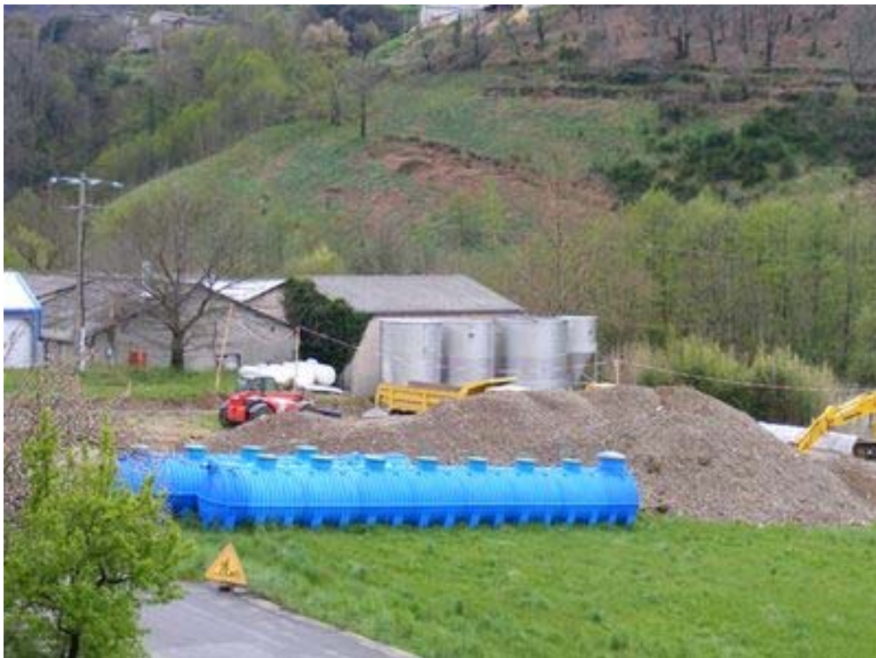
Début des travaux de la station d'épuration à la fromagerie
